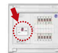
※漏電遮断器(参考写真)
